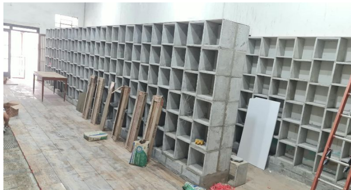
A expansão do Cinerário continua! Em fase de colocação do piso, deve concluir esta semana.
